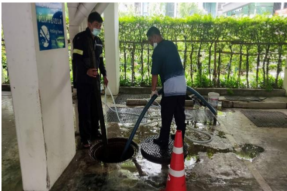
รูปที่ 9 การสูบบ่อเกรอะ
