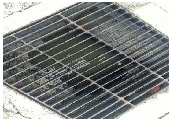
รูปที่ 14 ตะแกรงกรองเศษขยะรอบท่อระบายน้ำ
