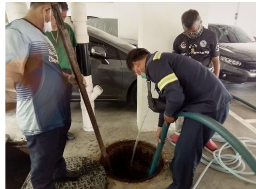
รูปที่ 9 การสูบบ่อเกรอะ
