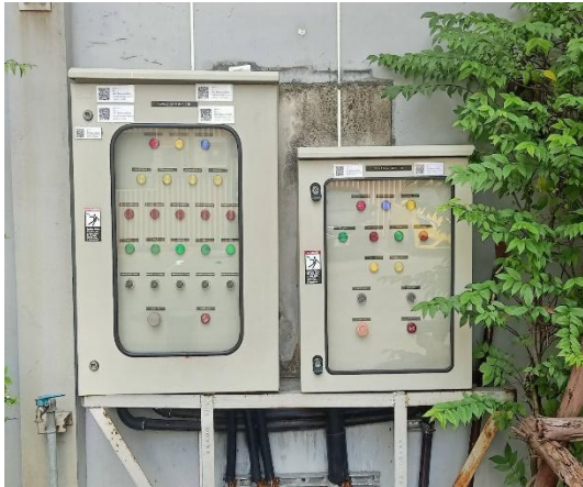
รูปที่ 30 ตู้ควบคุมระบบบำบัดน้ำเสีย
